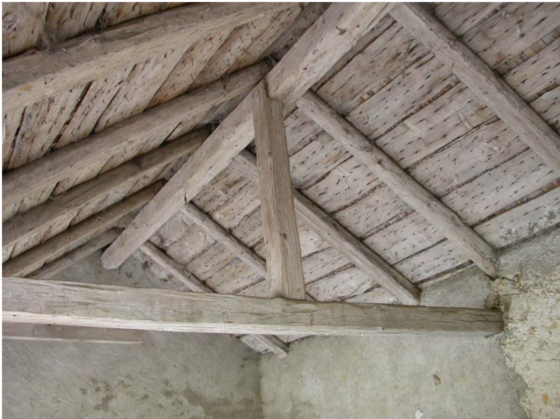
Fontaine couverte des Piguet-dessus, avec ci-dessous sa belle charpente à l'ancienne, avec les clous des tavillons plantés dans les lambris.
