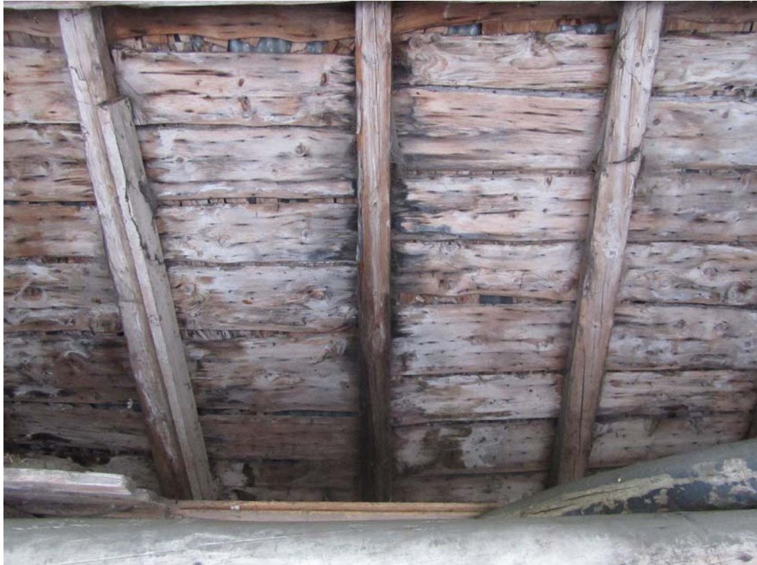
Toit fontaine couverte du Bas-des-Bioux
